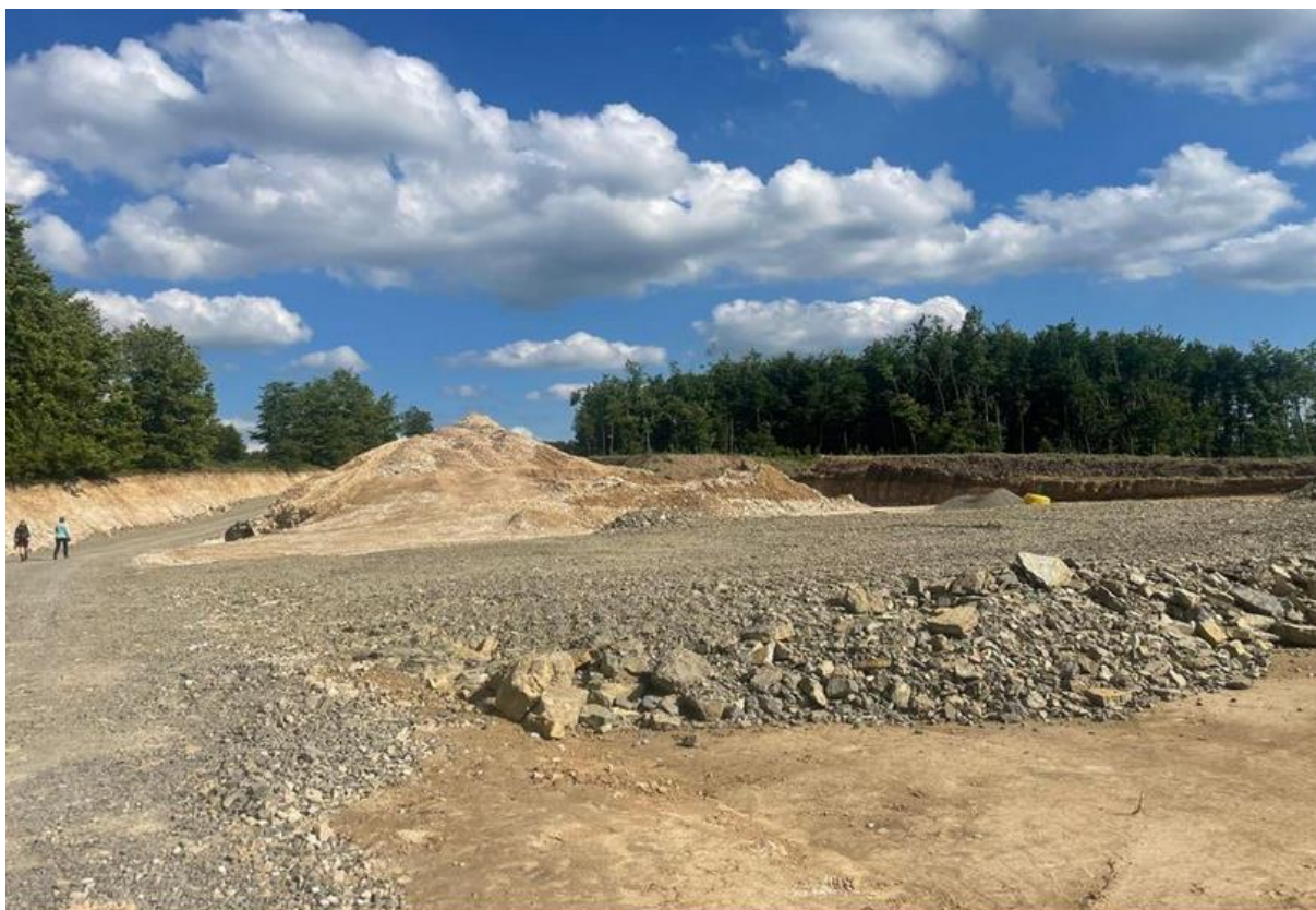
Bauarbeiten für Windräder im Wald, 8. Juni 2025, Reinhardswald/Hessen Foto frei von https://www.facebook.com/rettetdenreinhardswald
