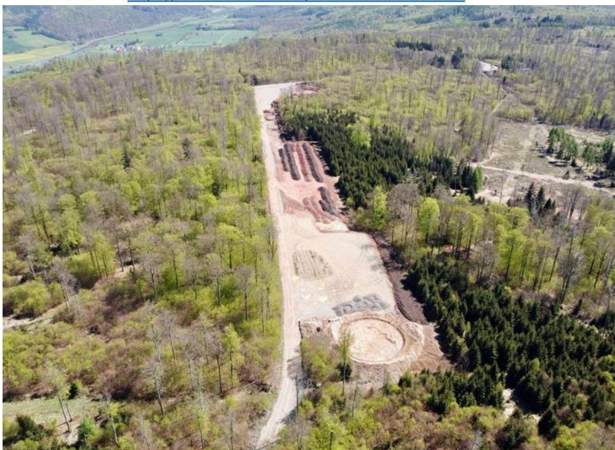
Bauarbeiten für Windräder im Wald, 8. Juni 2025, Reinhardswald/Hessen Foto frei von https://www.facebook.com/rettetdenreinhardswald
